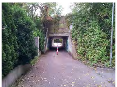
Unterführung Augsburgener Straße
