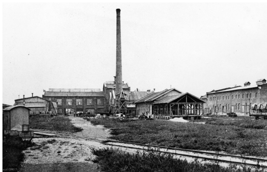
Verwertungsanlage, im Vordergrund die Bahngleise.
