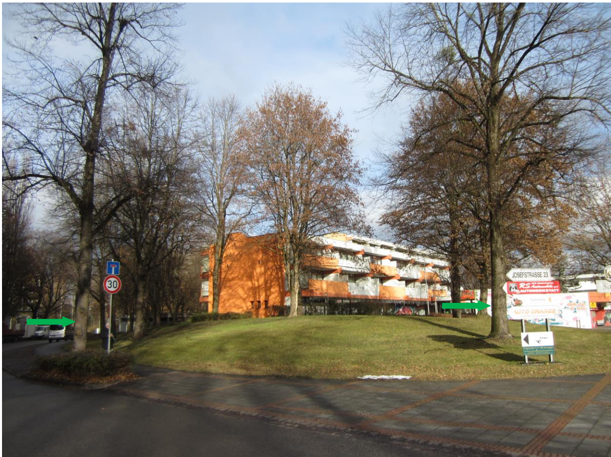
Foto 1: Südwestseite des Areals – die Bäume mit den Nr. 61-78 sind grundsätzlich vital und durchaus erhaltenswert- so wurden die im vorderen Bereich des Bildes stehenden Bäume mit den Nr. 64 und 65 (grüner Pfeil) auch zur Erhaltung festgesetzt (siehe Planskizze); notwendigerweise zu fällende Bäume könnten mittels Neupflanzung der Stärke 25-30 cm Stammumfang gut ersetzt werden.
